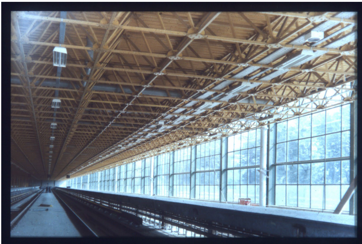
21.Kép. 4. Metró Központi Járműtelep (1982) Bp. X. Kőér utca. Kocsiszín, belső kép. A tartószerkezet un, KIPSZER-térrács. Színes dia 0002
