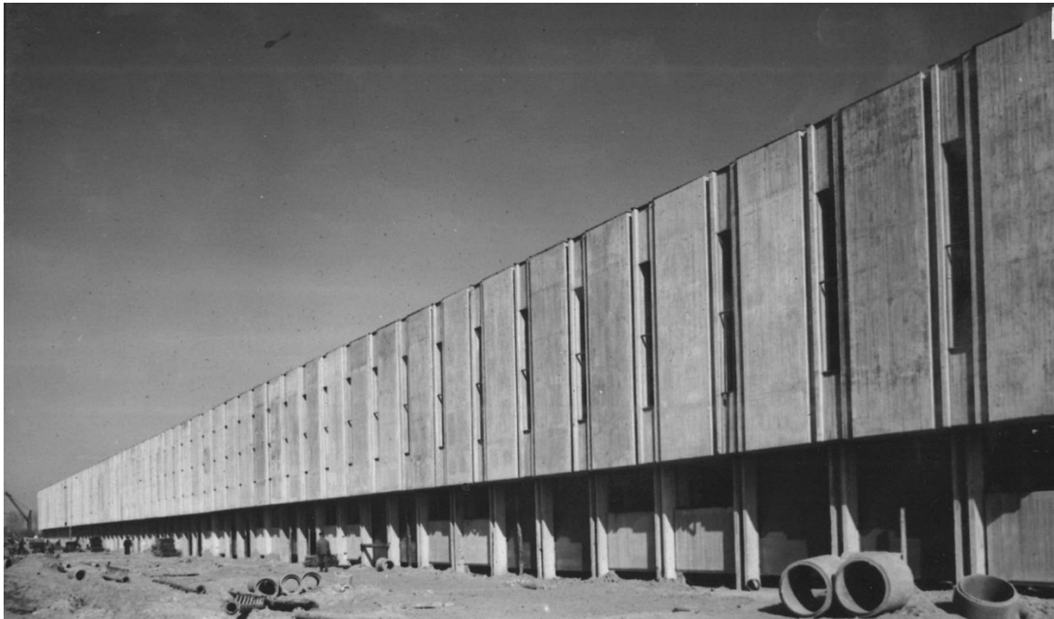
14.Kép. Debreceni Konzervgyár (1970) homlokzatrészlet. Egyedi előregyártású vasbeton homlokzati panelekkel épült homlokzat. Földesi megtalálta a módját, hogy a rendszeren belül az eltérő funkciókhoz finoman differenciált homlokzati paneleket rendeljen.
