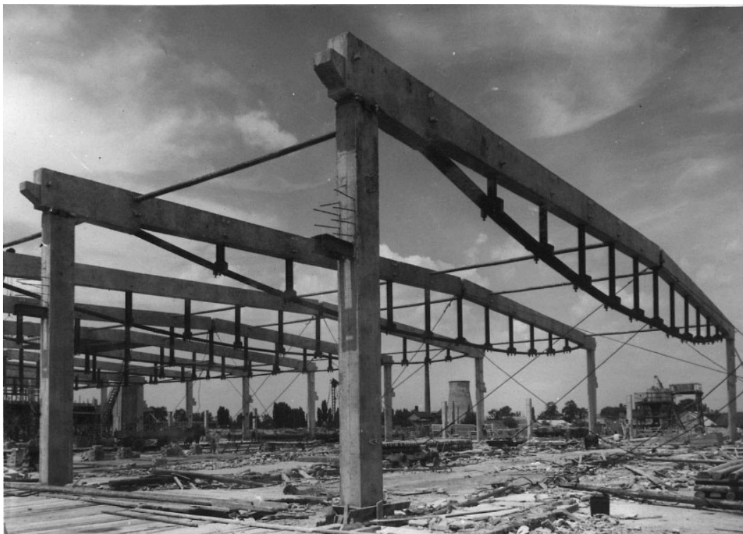
6.Kép. Nyíregyházi Konzervgyár szerkezetépítés. A feldolgozó munkatér az idényjellegű alapanyagokhoz igazodó változó gépesítésének átrendezhetősége miatt 40,00 m fesztávolságú csarnok. A szerkezet speciális: a két egyenes gerendából készült, közepén csuklóval összefogott vasbeton gerenda, az aláfeszítő acélszerkezettel lesz teljes. Nagy József szerkezettervező egyedi konstrukciója.
